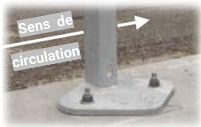
Support sur platine à 2 points d'ancrage
